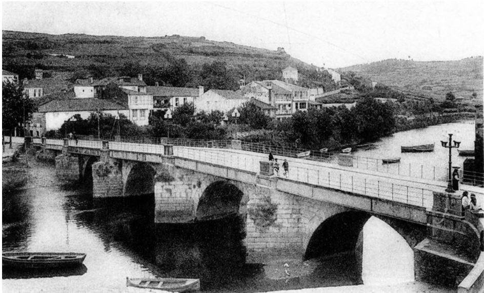
Vista general del Puente Viejo, río Mandeo abajo, con sus recién estrenadas farolas de luz eléctrica, en el primer tercio de nuestro siglo. (Archivo del autor).
