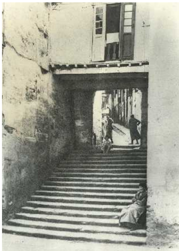
El voladizo construido sobre el Arco de la Puerta en 1727, y las escaleras instaladas en 1853 en sustitución de la antigua rampa medieval. Foto de Pedro Ferrer de principios del siglo XX, del archivo del autor.
