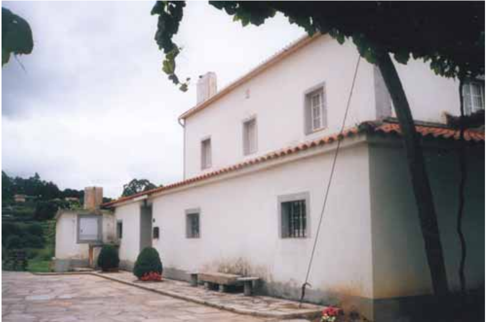
Pazo do Condado. Macenda de Arriba (Crendes). La chimenea superior señala el lugar donde se levantaba la torre.
