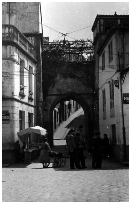
Puerta del Puente Nuevo, extramuros, circa 1950. Izquierda, antiguo solar de don Vicente Cabanas, con la cubierta convertida en terraza (archivo del autor).
