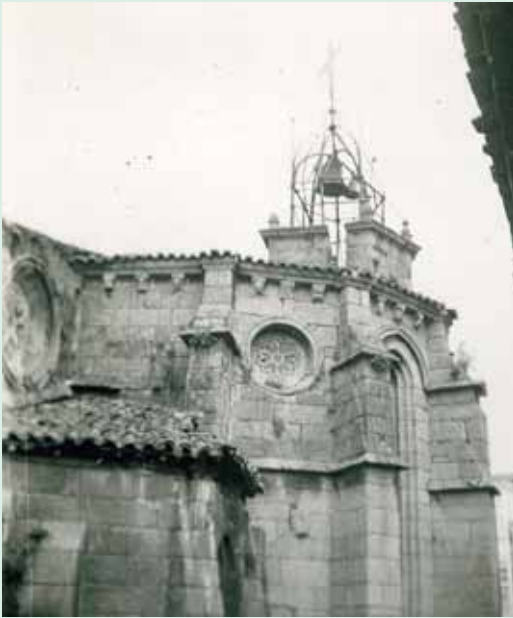
Sobre el ábside de la iglesia de Santiago, aparecen el pretil y el chapitel contruidos sobre el ajarafe de la Torre Municipal, con la boca de acceso. Foto tomada desde el callejón de «La Carrera» por el autor en 1965.
