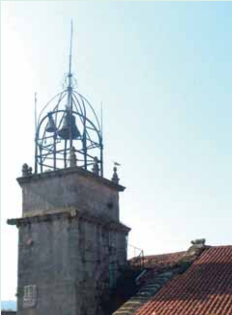
Torre del Reloj por el lado Norte.
